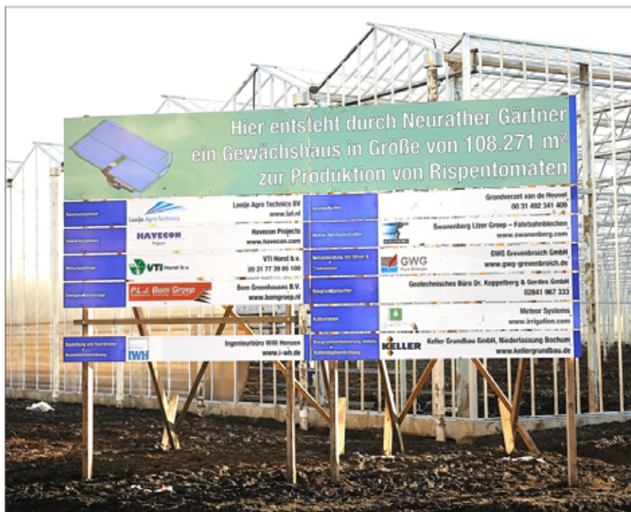
Bild 3: Baustellenschild am neuen Gewächshaus für Rispentomaten in Neurath
