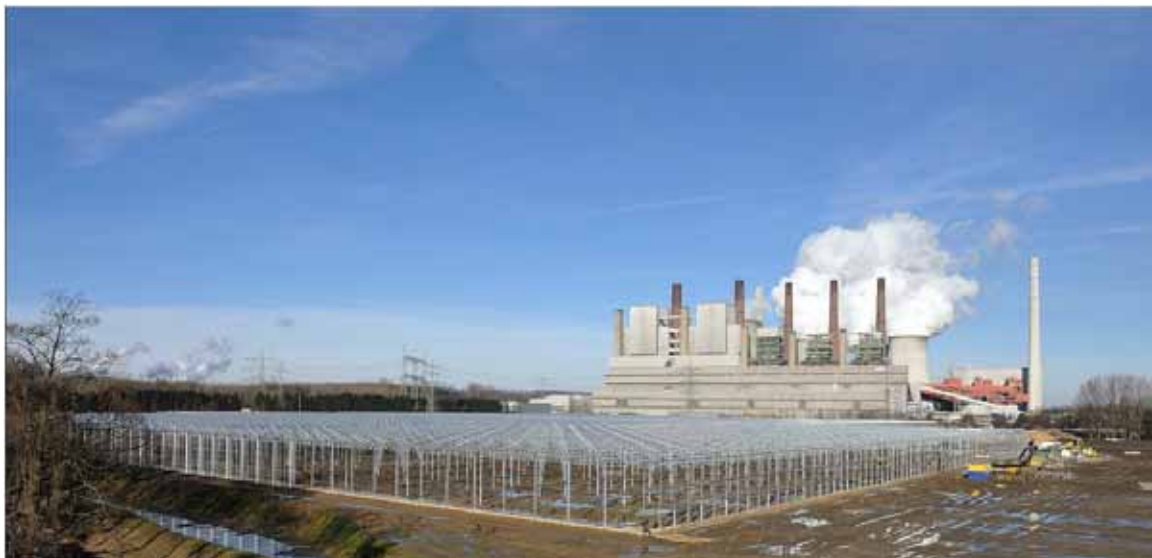
Bild 2.1: Das größte Gewächshaus Nordrhein-Westfalens mit einer Fläche von 108.271 m 2 geht im Jahre 2011 in Neurath in Betrieb. Es wird mit Wärme aus dem Kraftwerk Neurath beheizt.
