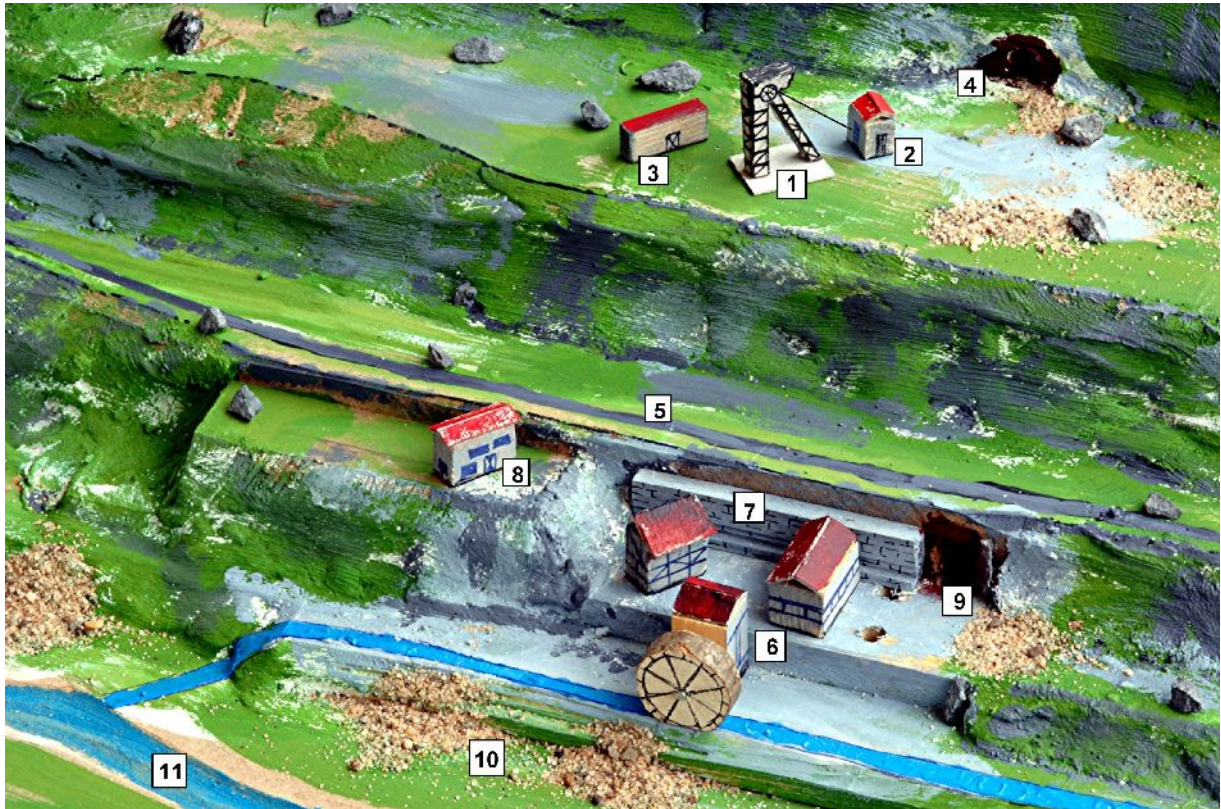
Bild 21: Grube Ziethen um 1860 im Modell mit Schacht 1, Aufbereitungsanlage und Stollen, die Zahlen im Bild bedeuten:
