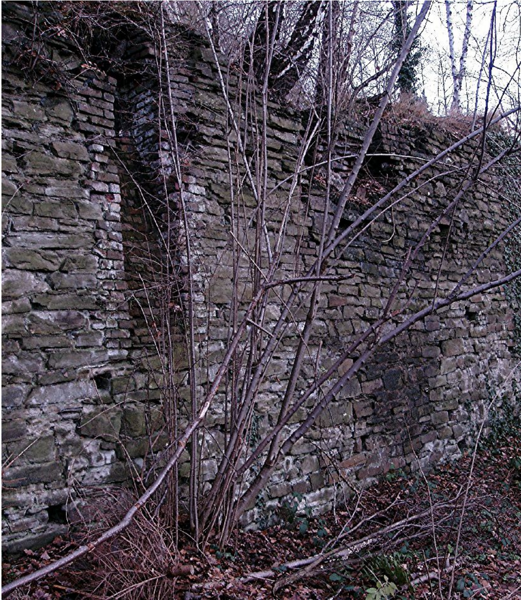
Bild 24: Stützmauer an der ehemaligen Aufbereitungsanlage im Jahre 2006
