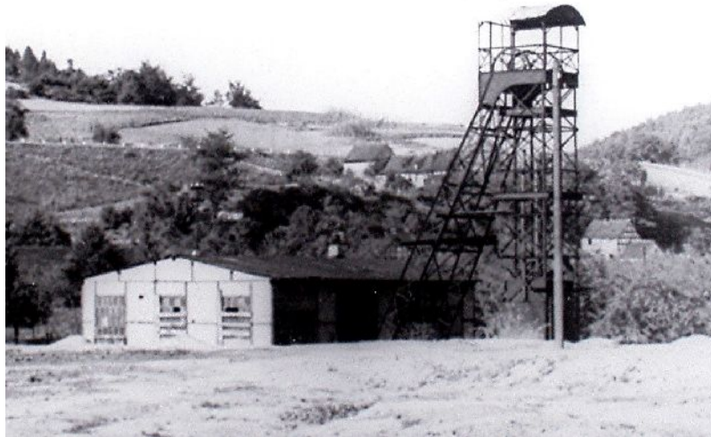
Bild 25: Schacht 3 der Grube Ziethen in Seligenthal
