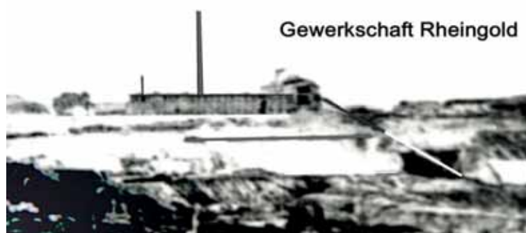
Bild 3: In den ersten beiden Jahren seines Betriebes trägt der Tagebau in Neurath den Namen Rheingold
